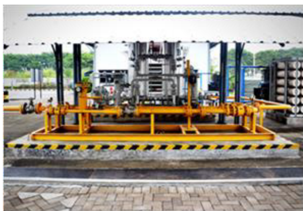
Gas Metering - Sidoarjo
